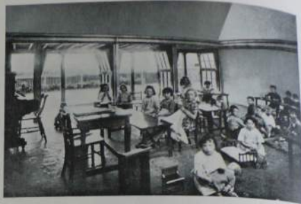
Ländliche Elementarschule in Fildern (Derbyshire) Arch. George H. Widdows Bauherr: Derbyshire County Council Trennung von Belichtung und Ventilation: Zur Belichtung die 60° geneigten Oberlichter, zur Ventilation die auf beiden Langseiten nach Veranden geöffneten Türen, von denen bei schlechtem Wetter der Oberteil allein aufgeklappt werden kann. Heizung durch Röhren unter dem Fussboden
