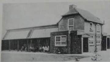
Ländliche Elementarschule in Fildern (Derbyshire) Arch. George H. Widdows Bauherr: Derbyshire County Council Trennung von Belichtung und Ventilation: Zur Belichtung die 60° geneigten Oberlichter, zur Ventilation die auf beiden Langseiten nach Veranden geöffneten Türen, von denen bei schlechtem Wetter der Oberteil allein aufgeklappt werden kann. Heizung durch Röhren unter dem Fussboden
